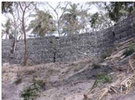
CONSTRUCCIÓN DE MURO A BASE DE GAVIONES
