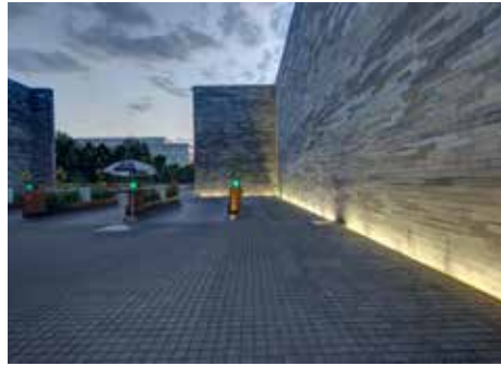
OBRAS EXTERIORES EMPRESALIA QUERÉTARO
