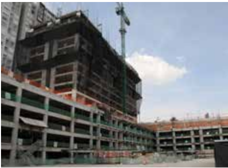
RESIDENCIAL SAN ÁNGEL CASA CLUB Y VIVIENDA
