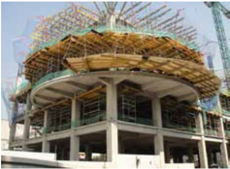
EDIFICIO PARA HOSPITAL SAN ANGEL INN MITIK
